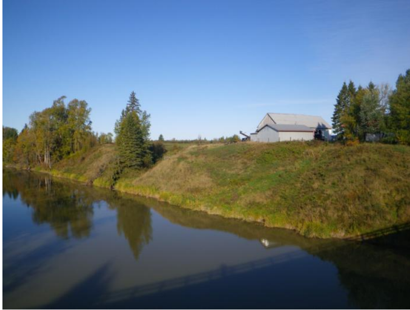
Berge avant les travaux
