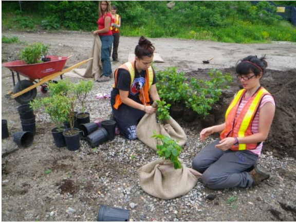
Confection des poches d'aulnes crispés pour la végétalisation de l'engrochement
