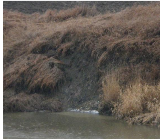
Foyer d'érosion majeur sur la berge
