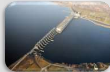
Réservoir journalier Carillon
